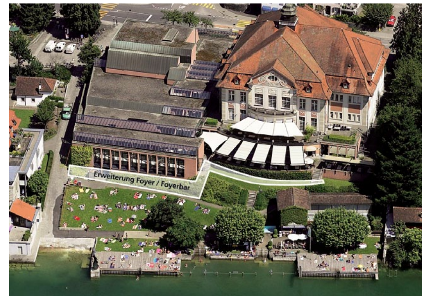
Schematische, nicht massstäbliche Darstellung des Streifens, der für die Foyererweiterung benötigt würde.
