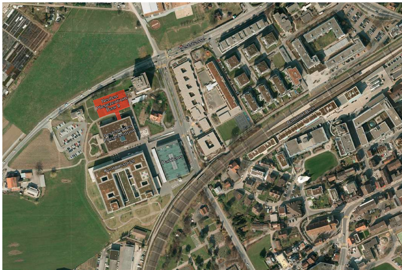
Luftaufnahme mit dem Neubau des Pflegezentrums II (rot).
