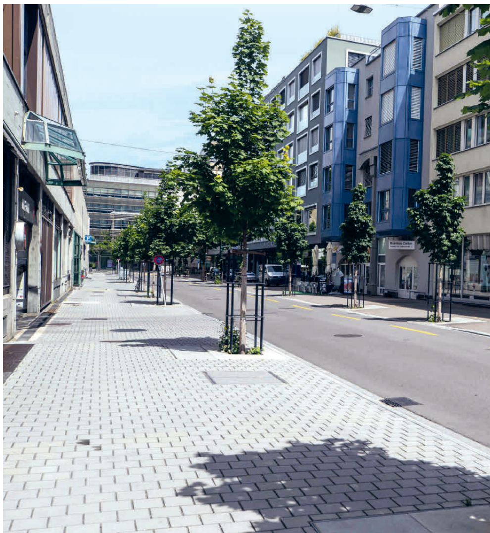
Auch der Gehweg entlang der Poststrasse wurde so umgestaltet, dass das Regenwasser zwischen den Verbundsteinen versickern kann.
