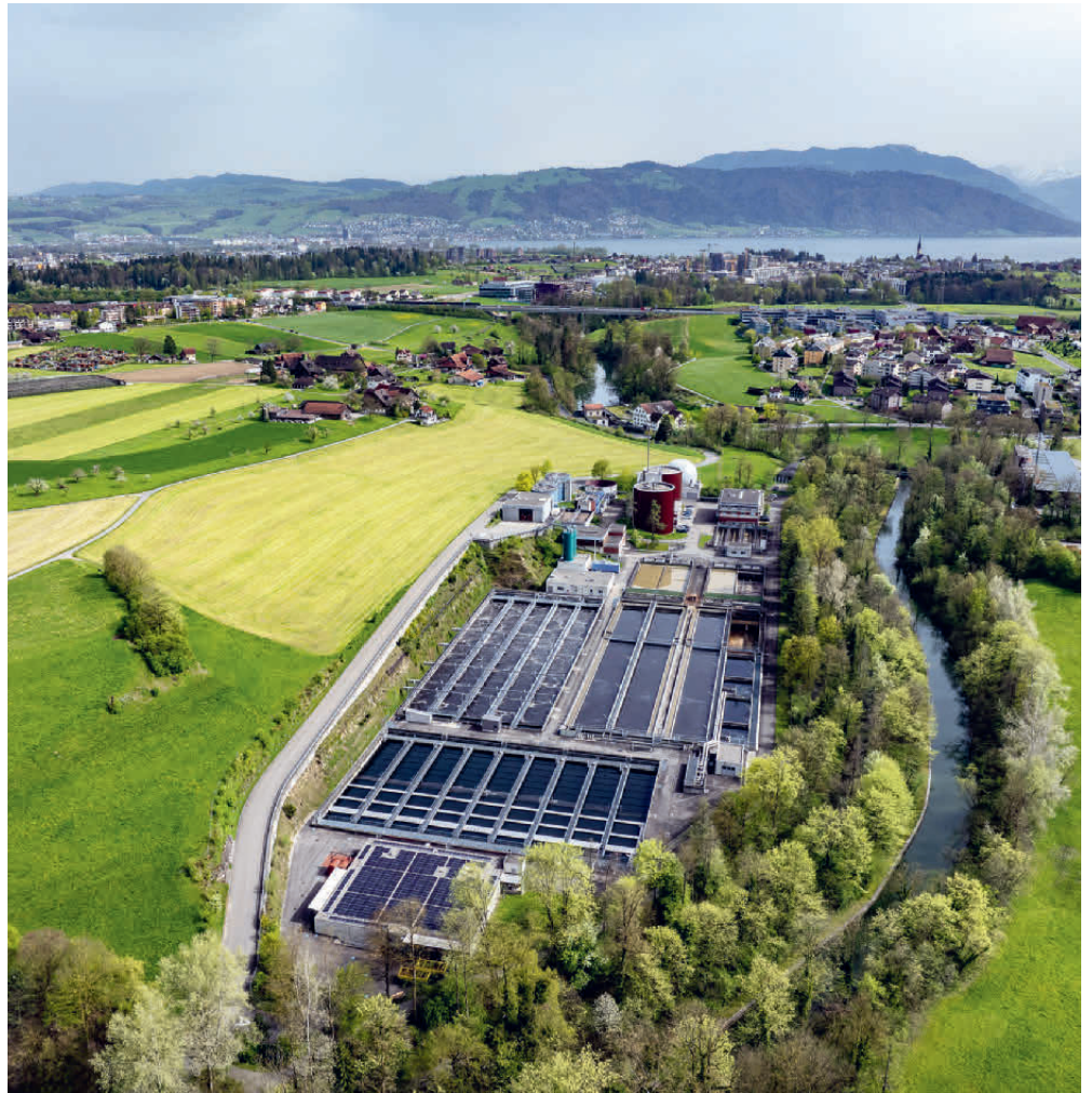
In der ARA Schönau in Cham durchläuft das Abwasser eine Reihe von Reinigungsstufen.
