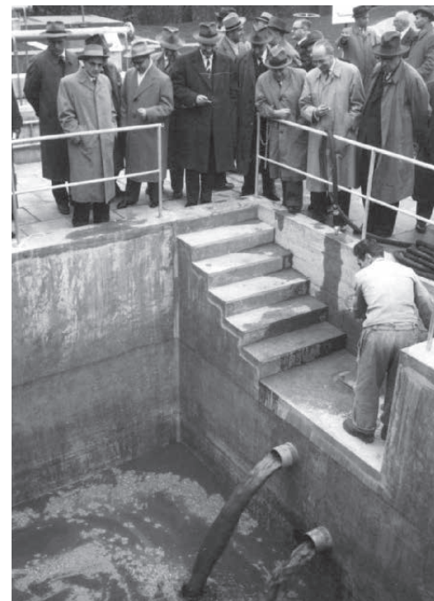
1957 wurde die erste Kläranlage in der Stadt Zug und 1977 die neuere Abwasserreinigungsanlage (ARA) in Cham in Betrieb genommen.
