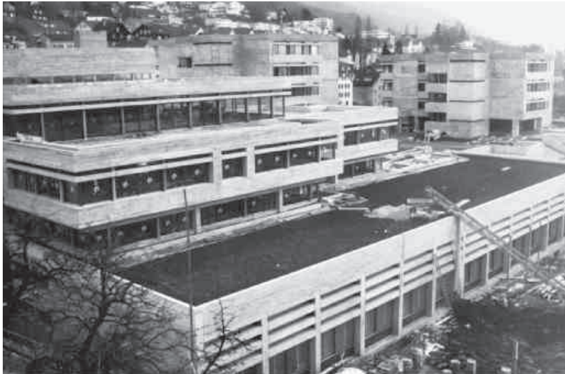
Ein Schwerpunkt der ersten Legislatur lag beim Bau von Schulhäusern: Ein grosses Geschäft war das Schulhaus Loreto.
