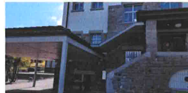
Blick auf das Vordach (links), von Westen her welches ersatzlos abgebrochen werden soll!
