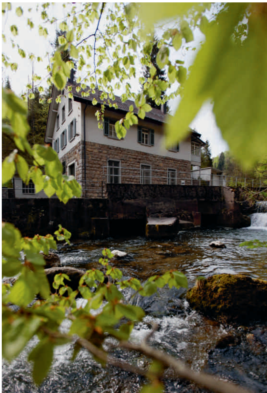
Lorzenkraftwerk «Zentrale 3» an der oberen Lorze.
